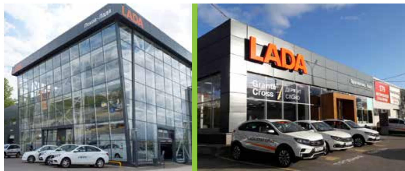
Псков-Лада после реконструкции
